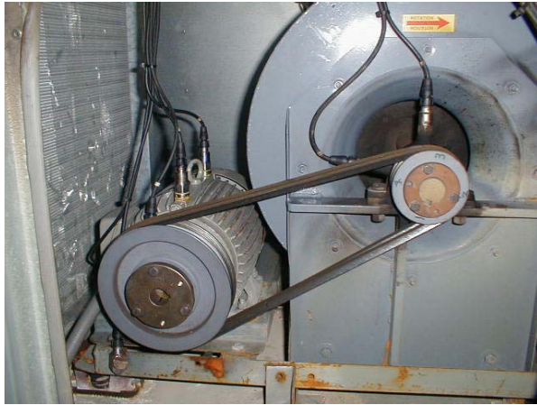
电机和轴承上安装的永久型 加速度振动传感器
